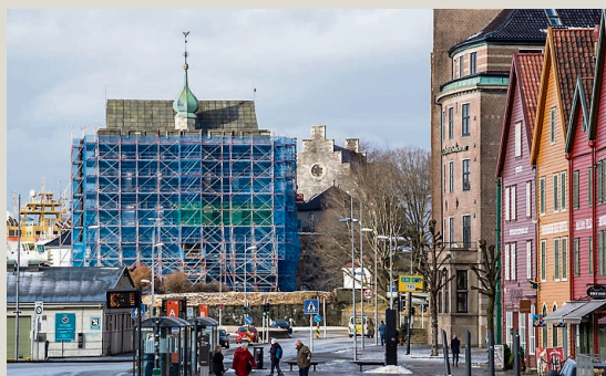
PUSSES OPP: Rosenkrantz-tårnet innpakket i blå (!) plast, og det har sammenheng med at vinduene i tårnet gjennomgår en nødvendig renovering. Tårnet er likevel åpent, og det er mulig å spasere rundt på toppen.
