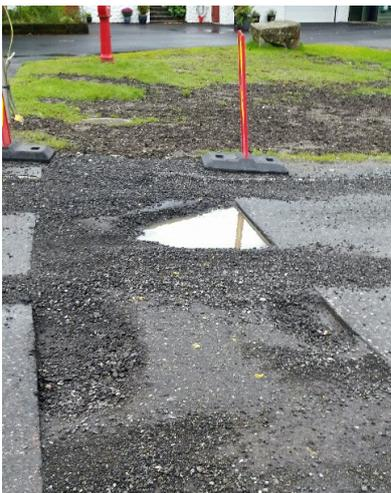
Ei grøft over RV544 i Sæ, treng sårt påfyll av både grus og asfalt for ikkje å bli eit slaghol av dimensjonar. Vonleg er «rette instans» snart på plass med rette fyllstoffet.
